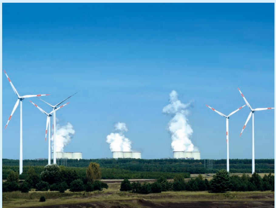
Konventionelle Kraftwerke leisten heute und in Zukunft einen wichtigen Beitrag zur Systemsicherheit im Stromnetz Fotolia | visdia
